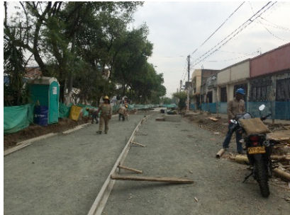
Instalación de Formaleta
