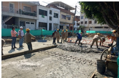
Extendido del concreto con regla vibratoria
